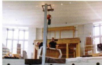
●吊り上げ作業
